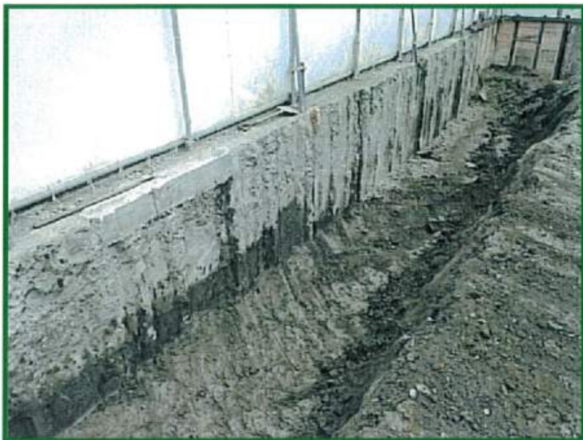
打設完了後 掘削状況
