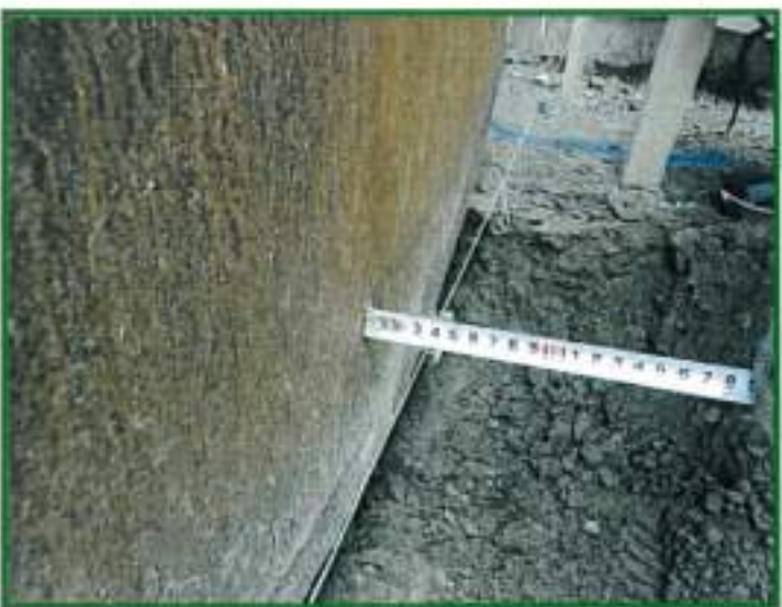
6. 掘削前の確認
