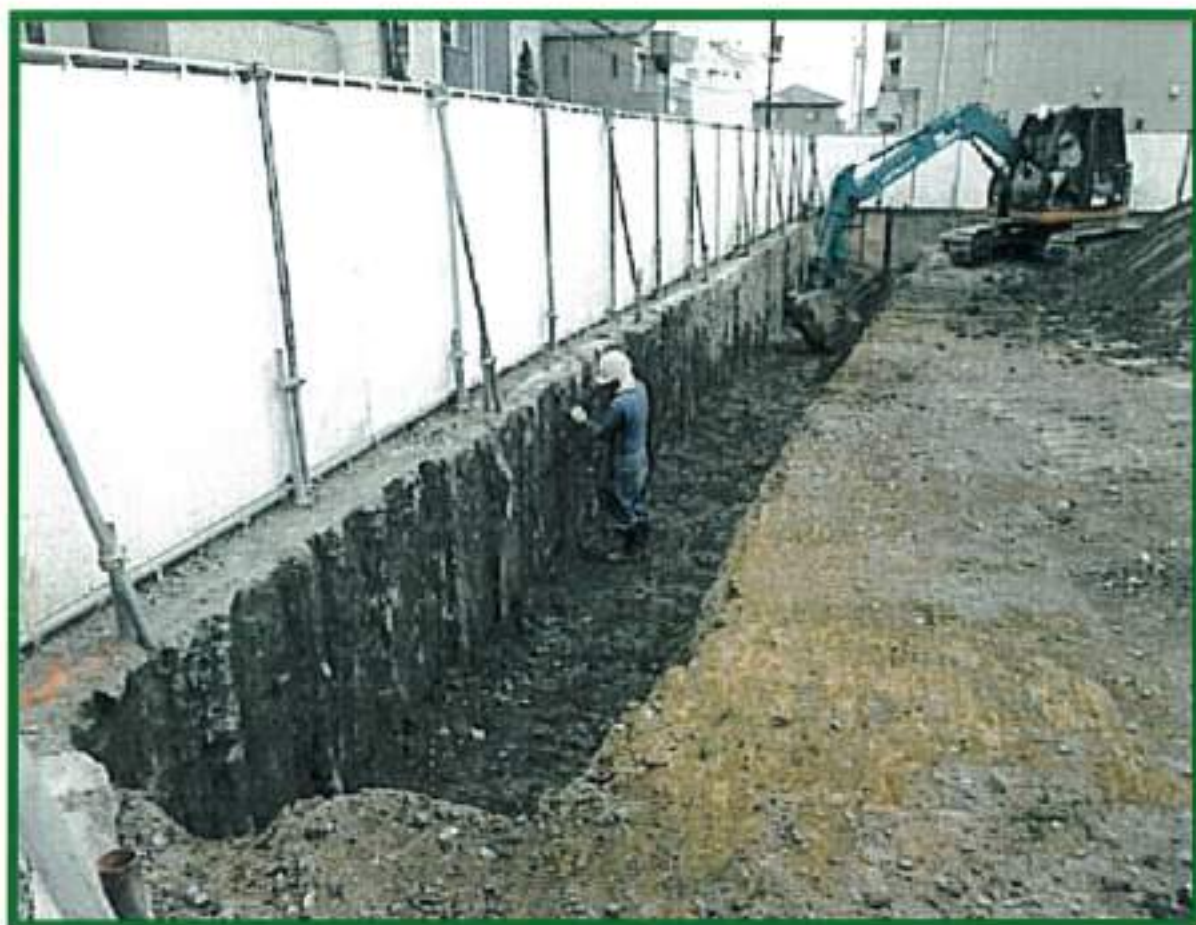
打設完了後 掘削状況
