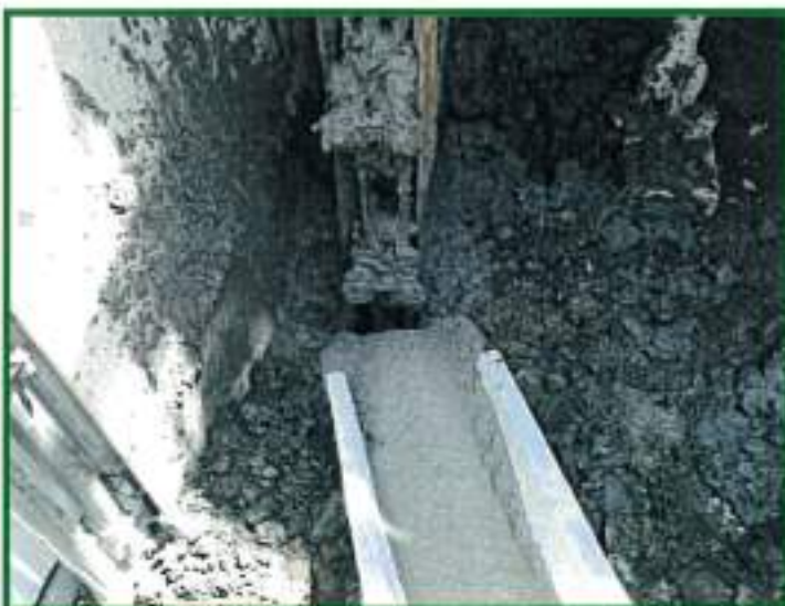
11.コンクリート打設 生コン21-21-15 (豆砂利)
