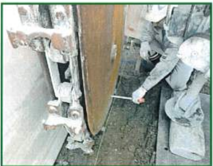
5. 掘削前の確認
