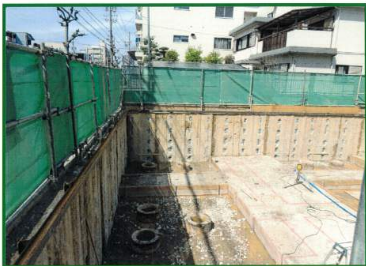
頭継ぎ セパ溶接用研り状況
