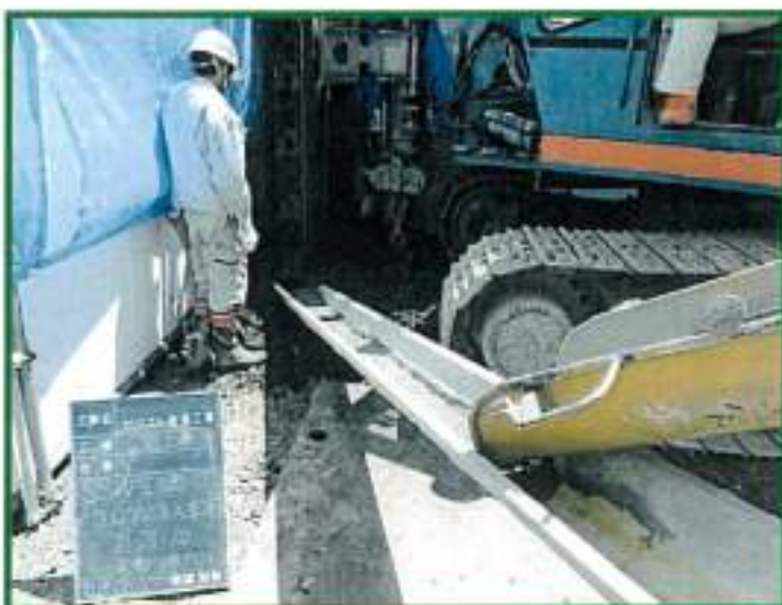
10.コンクリート打設 生コン21-21-15 (豆砂利)
