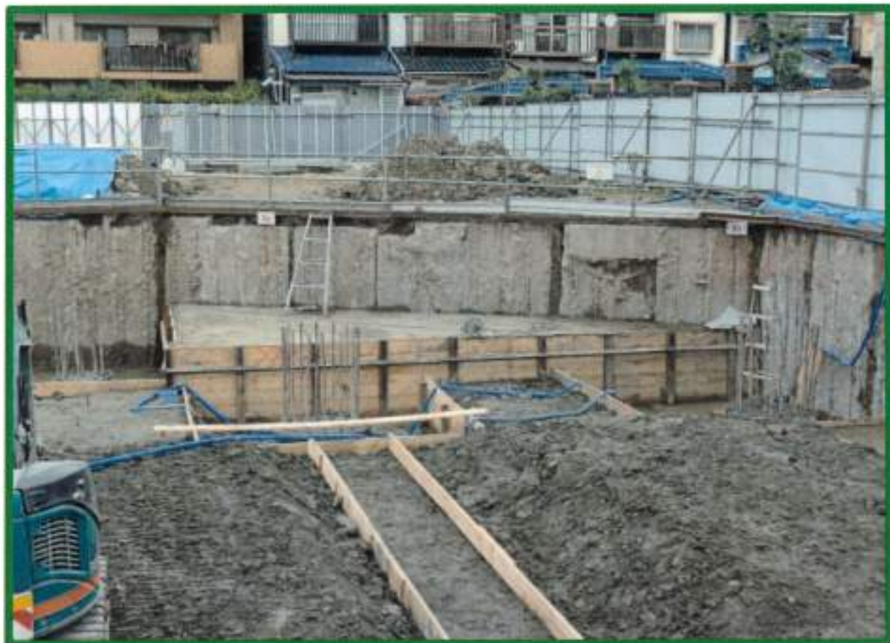
掘削段差による土留状況
