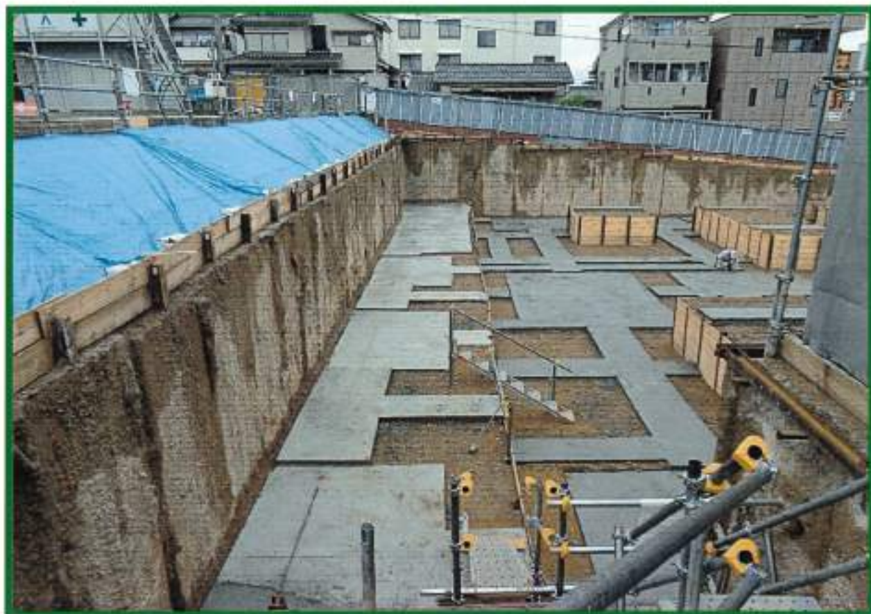
捨コン打設完了
