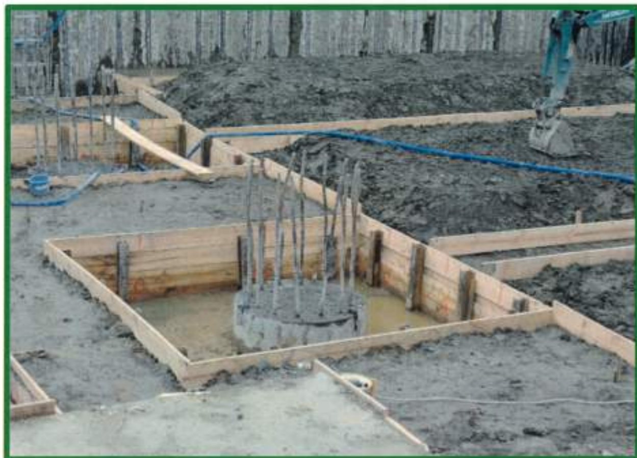
杭頭研り後 ベース枠設置
