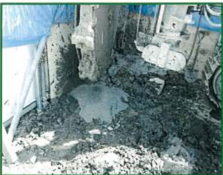
12.コンクリート打設 完了
