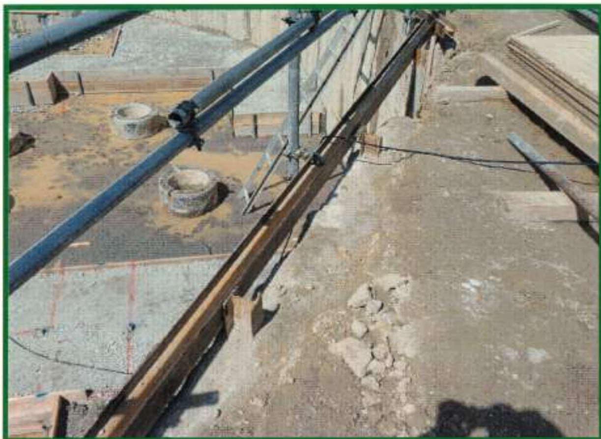
頭継ぎ セパ溶接用研り状況
