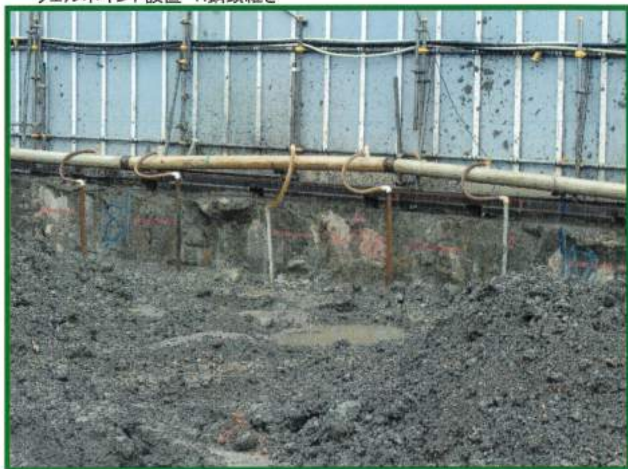
ウェルポイント設置 H鋼頭継ぎ
