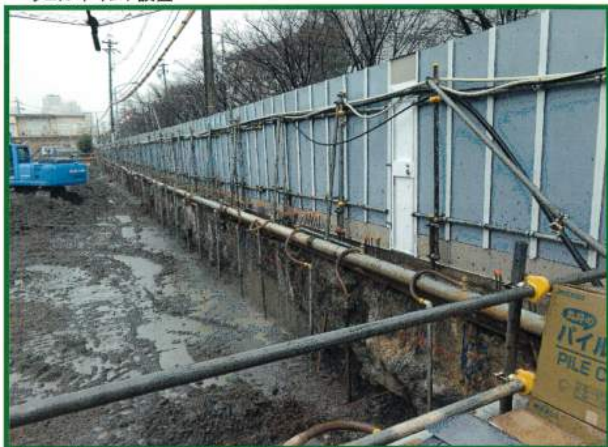
ウェルポイント設置 H鋼頭継ぎ
